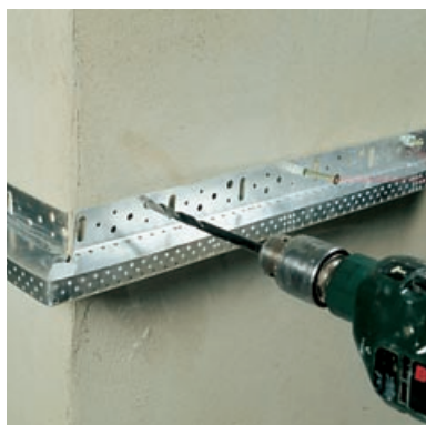
2. Пробиване на дупка
