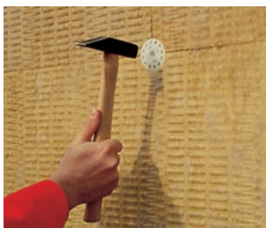
11. Забиване на дюбел
