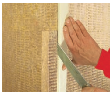
8. Изрязване на излишната изолация в ъгъла
