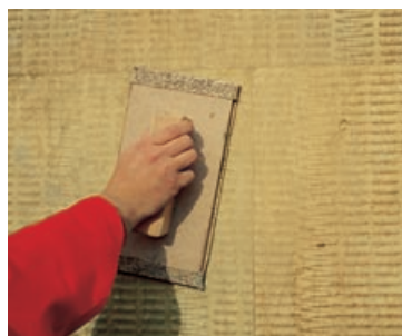
9. Почистване на плочата с шкурка
