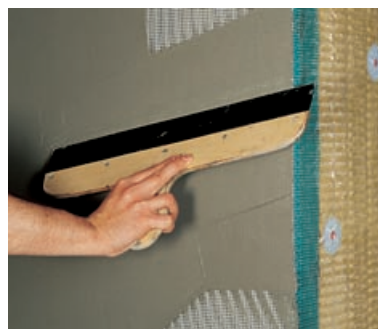
15. Поставяне на армиращата мрежа и изглаждане на шпакловката
