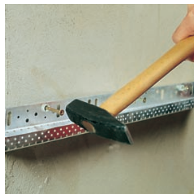
3. Забиване на винта с чук
