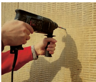
10. Разпробиване на отвор
