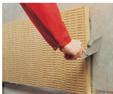
6. Отстраняване на излишното лепило
