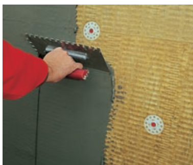
13. Полагане на шпакловъчна смес с гладката страна на шпаклата.
