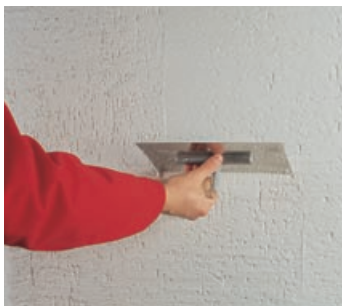
19. Шпакловане на мазилката
