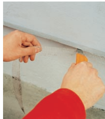
17. Изрязване на излишната мрежа
