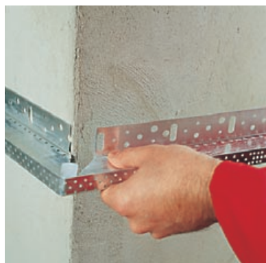
1. Премерване височината на цокълния профил
